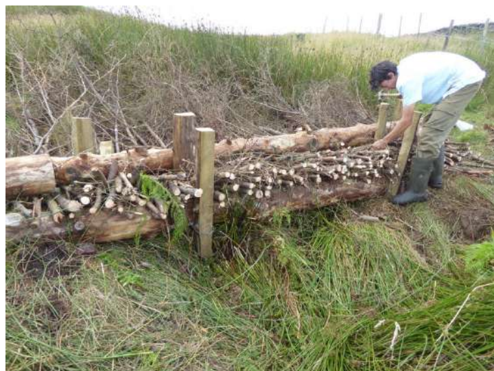
Fotografía 20 Adaptación en campo de los muros de retención con el material disponible en campo
